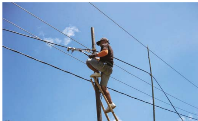
Gambar 7. Pemasangan kabel listrik
